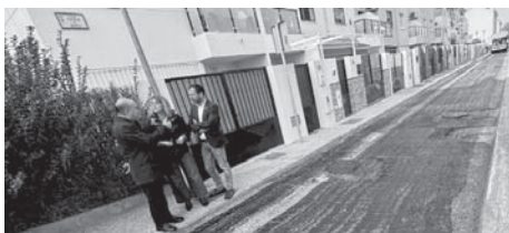
Reasfaltado en La Quinta VIVA
